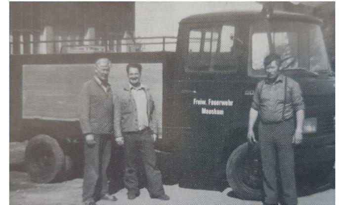
In unzähligen freiwilligen Arbeitsstunden wurden die Pumpe und die Haspel in der Landmaschinenfabrik von Oskar Morawetz auf einen angekauften Mercedes mit den geschickten Händen von Josef Stoiber aufgebaut, um somit das neue Tanklöschfahrzeug zu erhalten.
